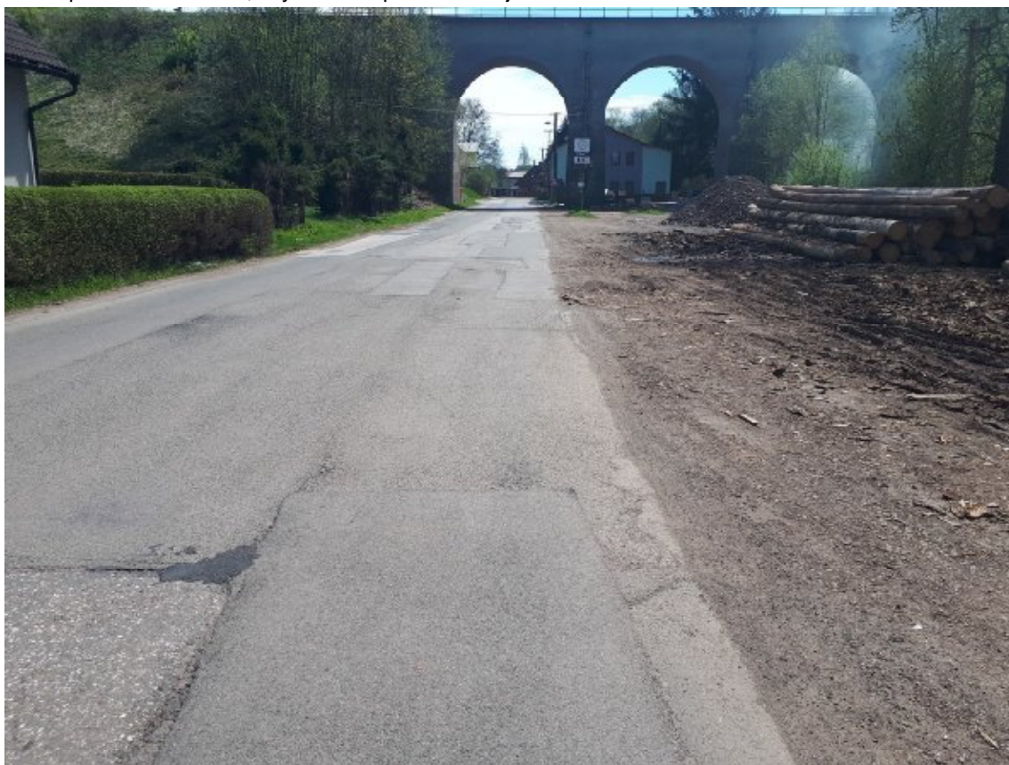
F235, km 16,585+ P Vysprávkování, mozaikové trhliny, nepravidelné hrboly, ztráta asfaltového tmelu, hloubková koroze.
