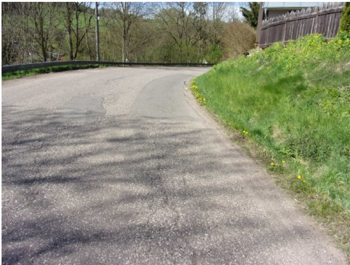
F069, km 15,540- L Ztráta asfaltového tmelu, hloubková koroze, mozaikové a podélné rozvětvené trhliny, vysprávký, zvýšená nebezpečná krajnice.
