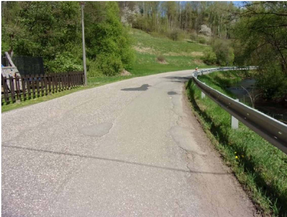
F202, km 14,935+ P Vysprávký, nepravidelné hrboly, mozaikové trhliny, olamování okrajů.
