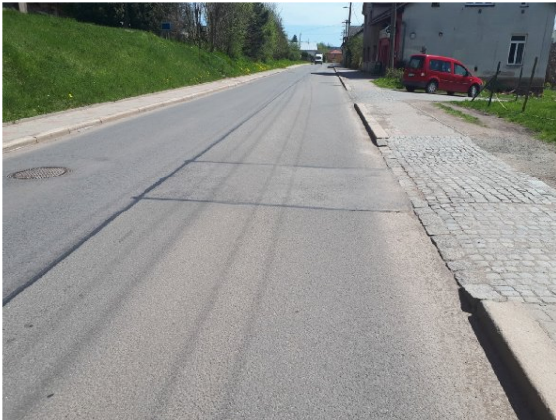
F265, km 18,085+ P Plošné výspravy, příčný překop.
