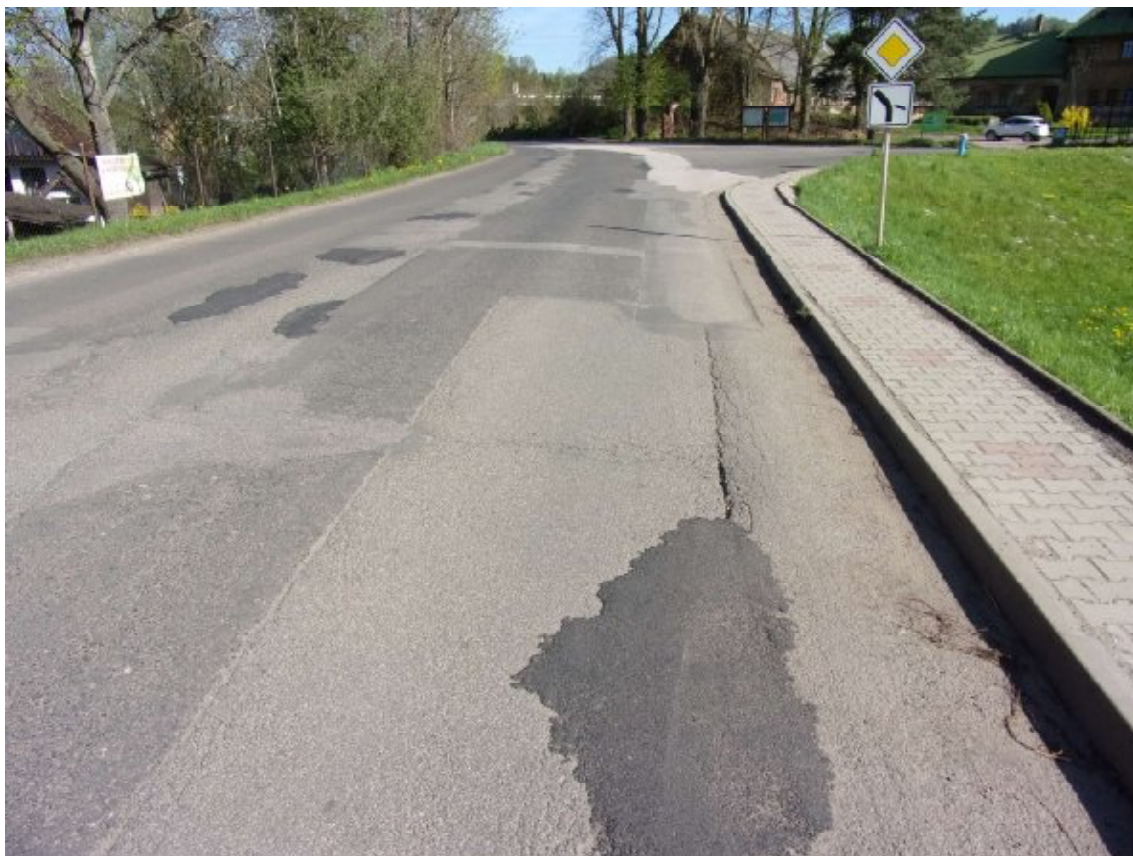
F003, km 18,840- L Vysprávký, nepravidelné hrboly, mozaikové trhliny, ztráta asfaltového tmelu, hloubková koroze.
