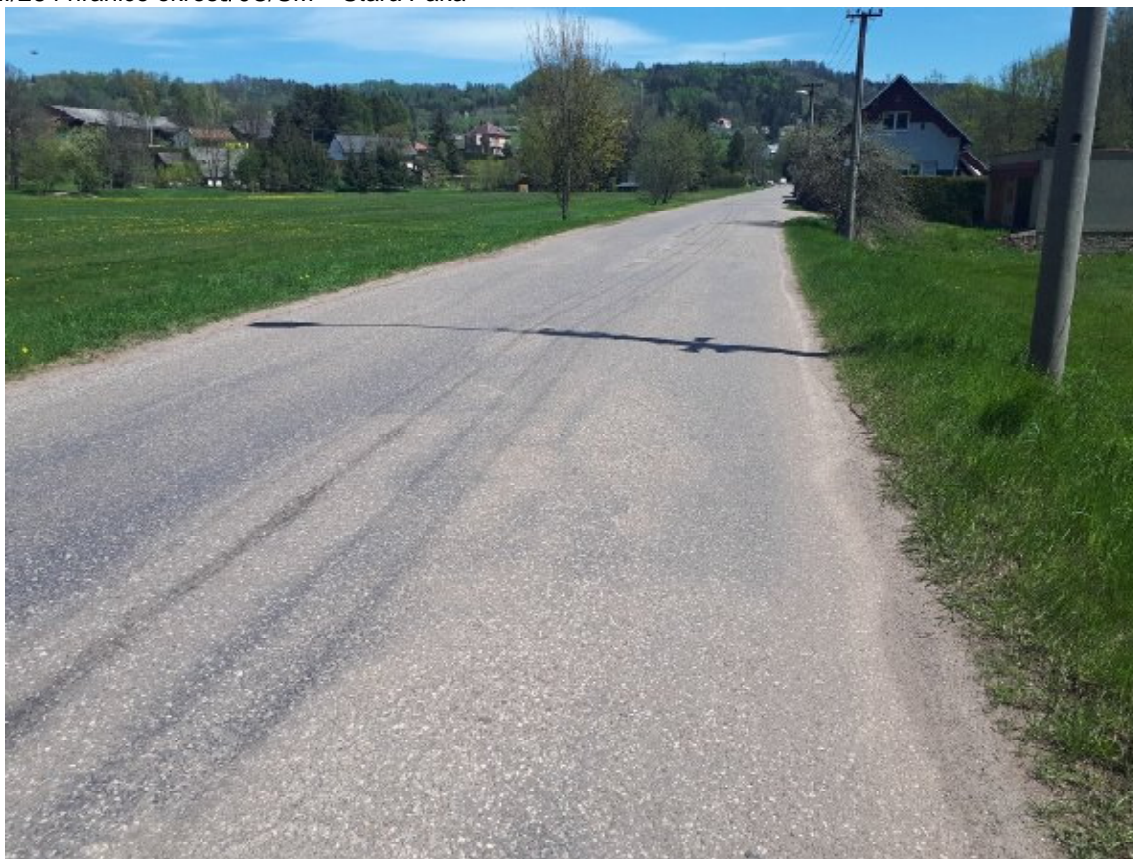
F223, km 15,985+ P Mírné plošné deformace, zvýšená nebezpečná krajnice.
